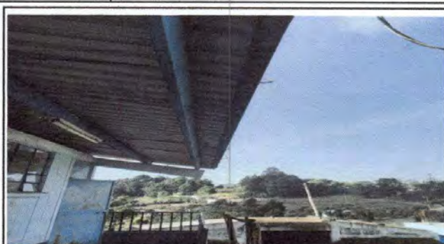
Foto 2: CANALES Y BAJADAS DE AGUA PLUVIAL
