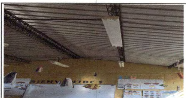
Foto 4: REPARACIÓN DE SISTEMA ELÉCTRICO
