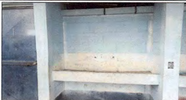
Foto 1: sustitución de grifos.
