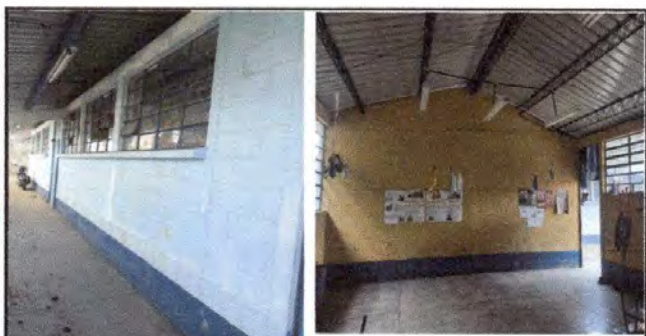
Foto 3: PINTURA DE MUROS EXTERIORES E INTERIORES
