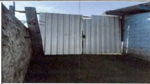
Foto 2: Sustitución de portón de metal.
